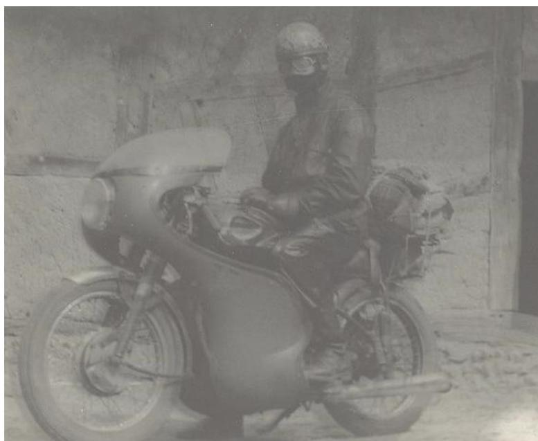
**1970 : Une rareté : un B33 (presque coursifié) avec pot type mégaphone, carénage fabriqué à l'usine de Holland Road, réservoir anachronique et, encore plus surprenant, l'échappement à gauche... à moins que le photographe...**
